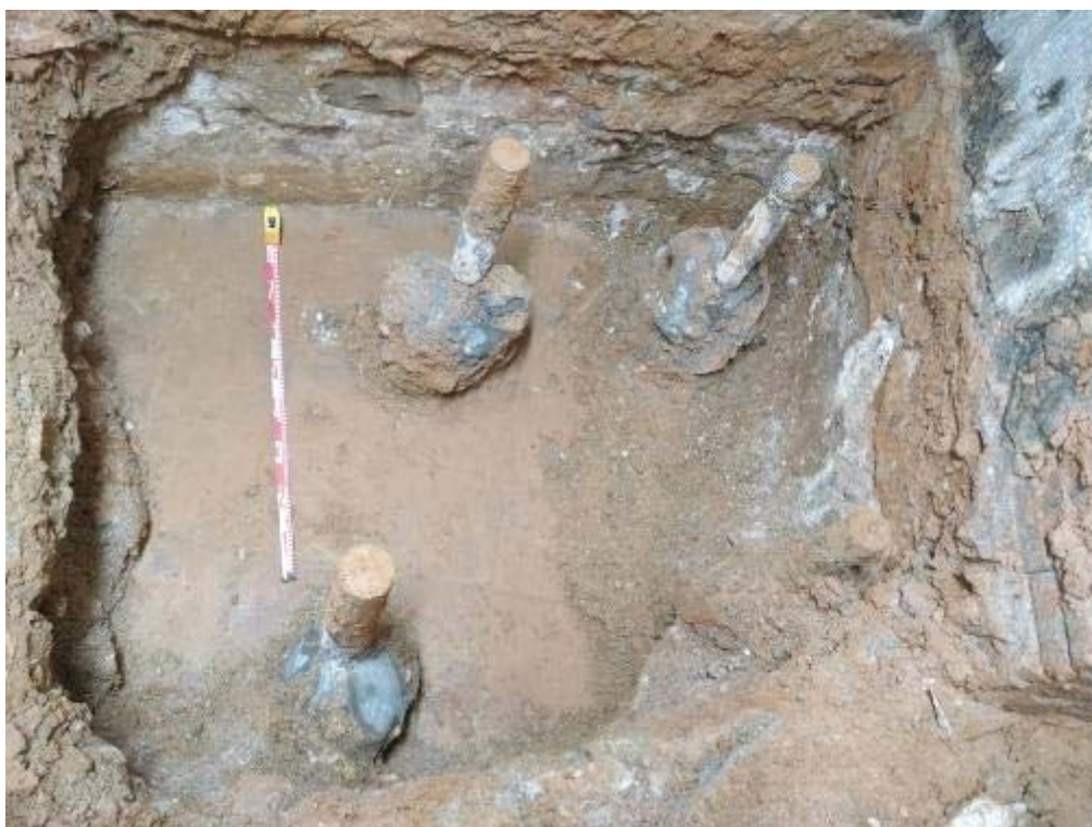
Foto 8: Encepat 2. Paviment UE 4
