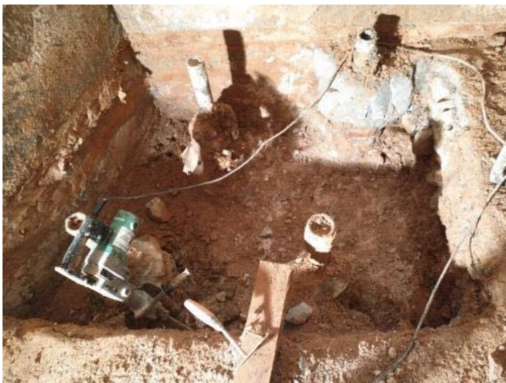
Foto 16: Encepat 4. Tasques d'excavació
