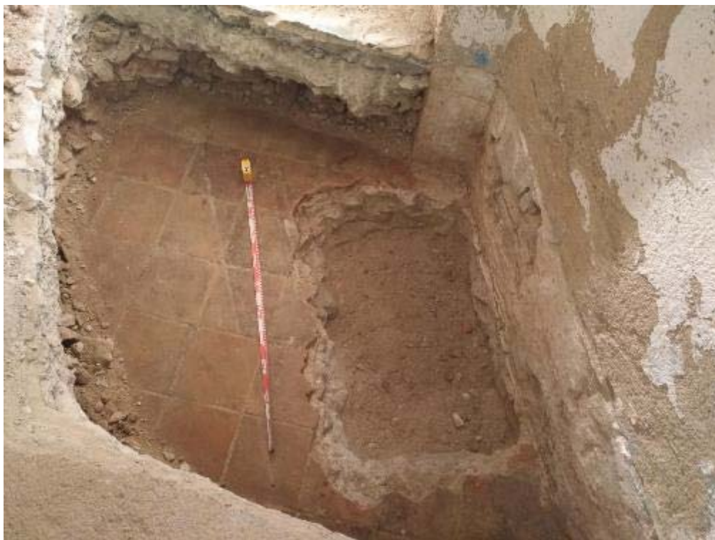
Foto 3: Encepat 1. Paviment UE 4
