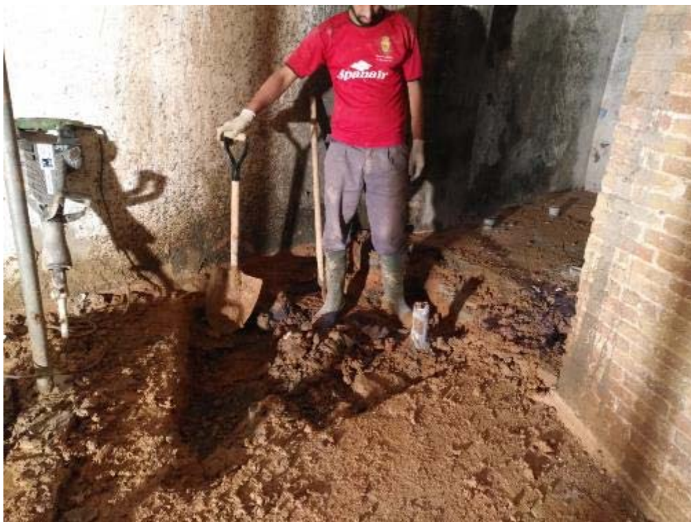
Foto 15: Encepat 4. Tasques d'excavació
