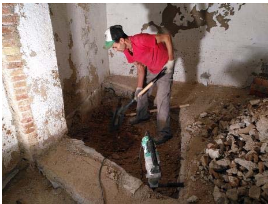
Foto 2: Encepat 1. Treballs d'excavació
