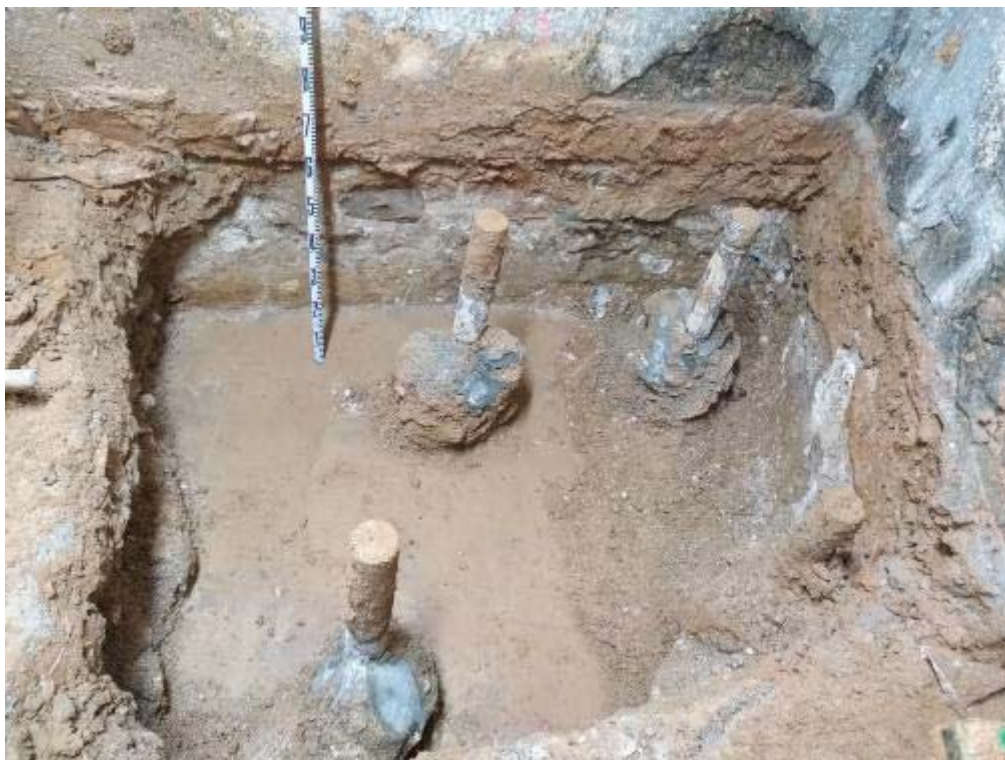
Foto 9: Encepat 2. Paviment UE 4 i mur UE 2
