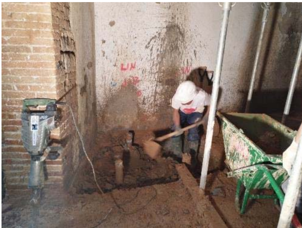
Foto 11: Encepat 3. Tasques d'excavació
