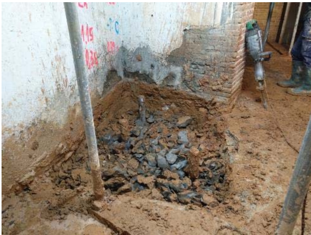
Foto 7: Encepat 2. Tasques d'excavació
